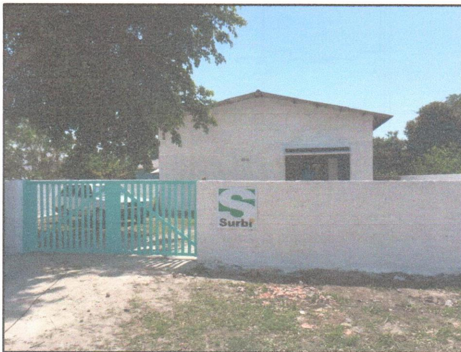
Estrutura com refeitório, dormitório, sanitários e almoxarifado para atender os colaboradores.
