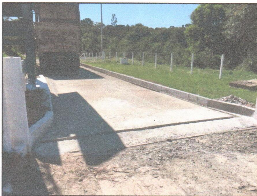
Canaletas coletoras de chorume e mureta de isolamento da área impermeabilizada
