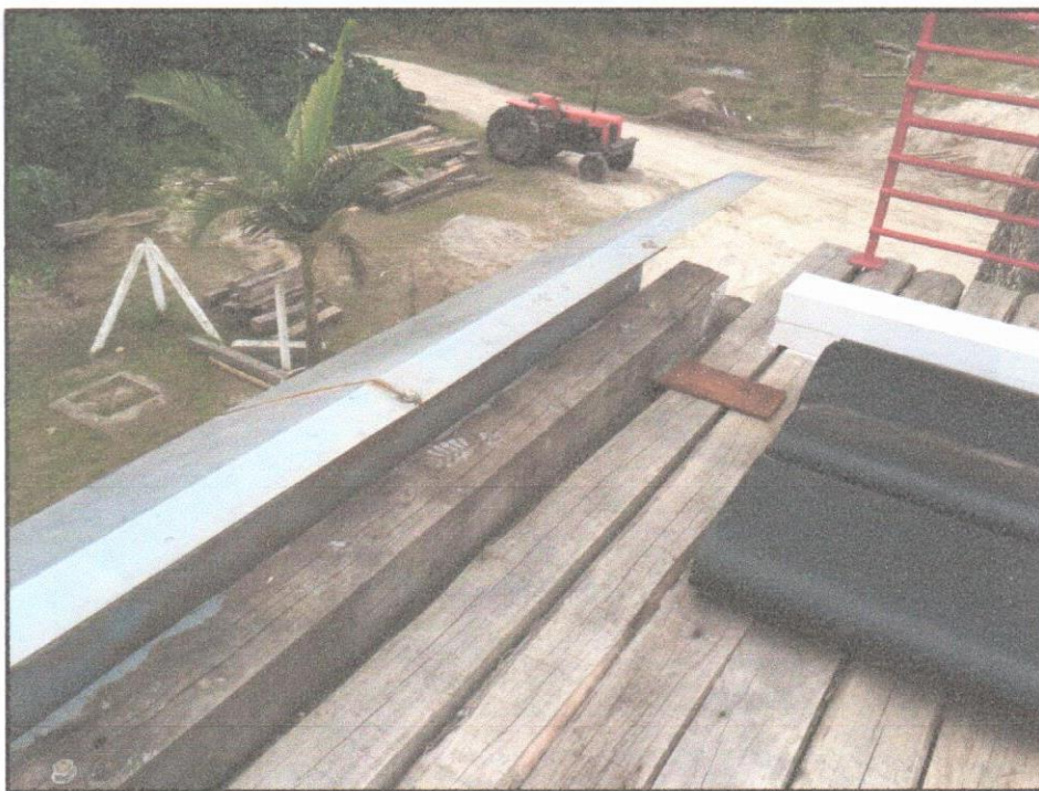
Batente metálico da rampa de descarregamento.
