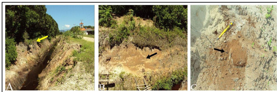
Figura 15 - As imagens fotográficas relacionadas mostram os tipos de solos presentes nas cercanias e no local de inserção da estação de tratamento o solo maduro, superficial, delgado, cinza escuro - seta em amarelo, seguido do solo saprolítico essencialmente arenoso, com 4,0m de espessura, marrom, sotoposto ao solo maduro - seta em preto.
