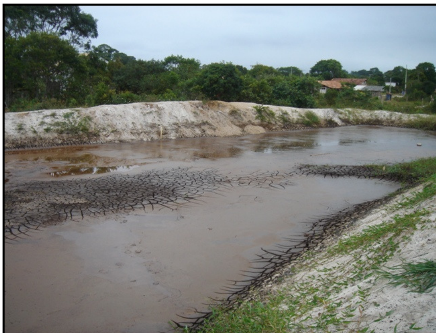
Figura 31 – Cava de Decantação de Lodo
