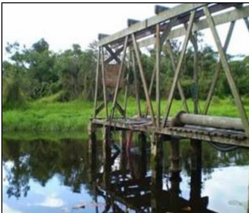
Figura 21 - Captação da ETA Principal – Rio Saí Mirim
