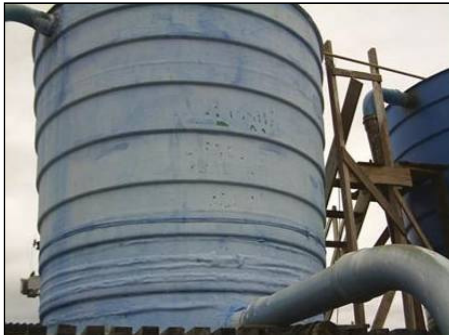
Figura 35 – Filtro Descendente
