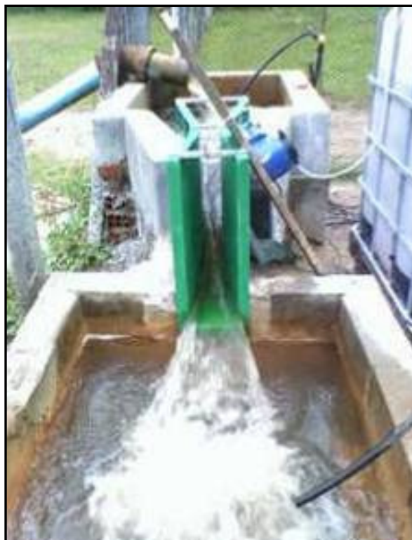
Figura 41 – Caixa de Amortização
