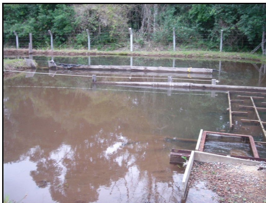
Figura 44 – Lagoa de Decantação
