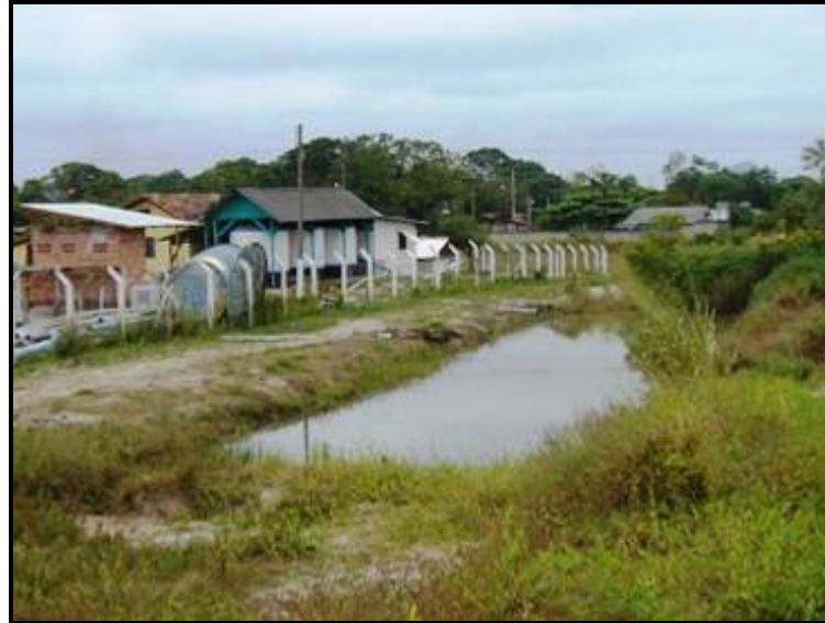
Figura 37 – Vala de Drenagem
