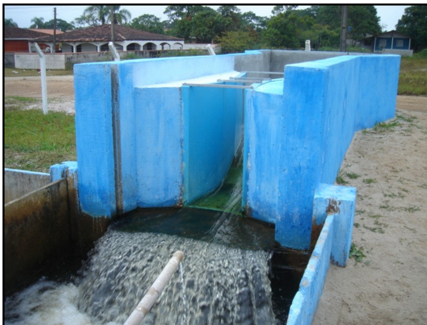
Figura 28 – Calha Parshall
