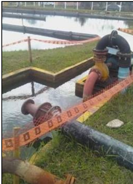
Figura 32 – Poço de Recalque da Água Clarificada nas Lagoas de Decantação
