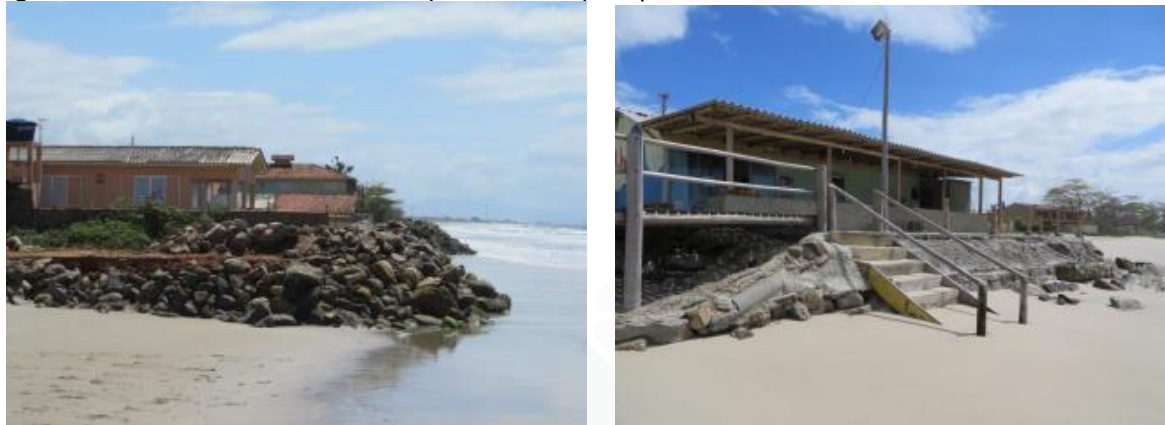
Figura 137: Pontos da orla do município afetados pelo processo de erosão costeira
