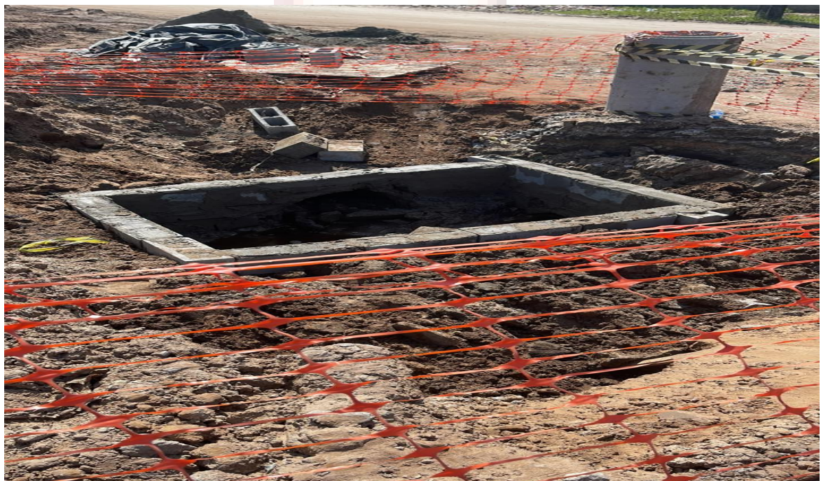
fig. 2 – Caixa de ligação de 60 cm, Estaca 0+320.
