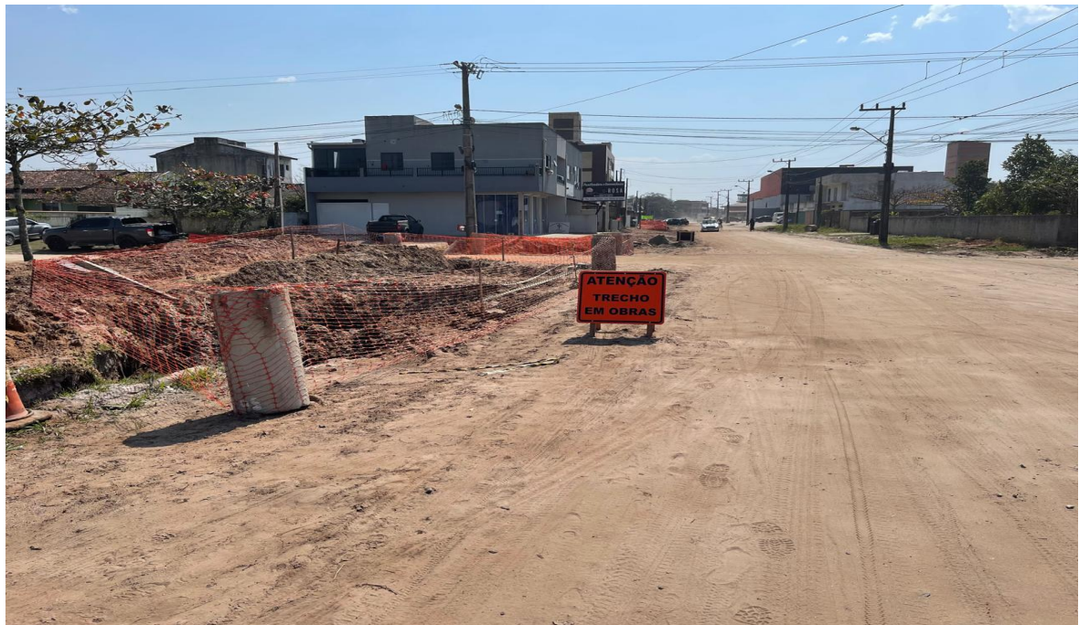
fig. 1 - Rede pluvial de 40 cm, deságue tubulação de 60 cm, Estaca 0+320.
