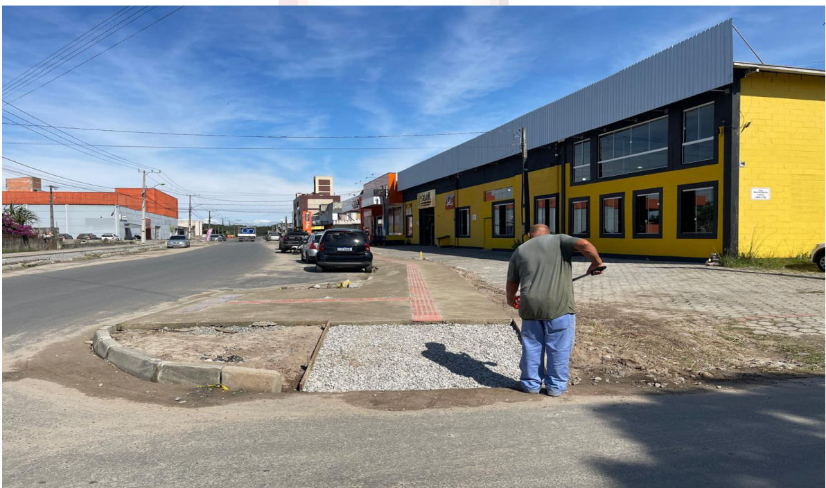
fig. 7 - detalhe dos ajustes nos meios fios, passeio.
