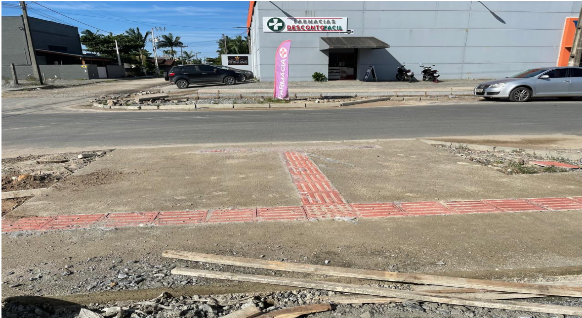
fig. 8 – acesso a travessia elevada, trecho do passeio.
