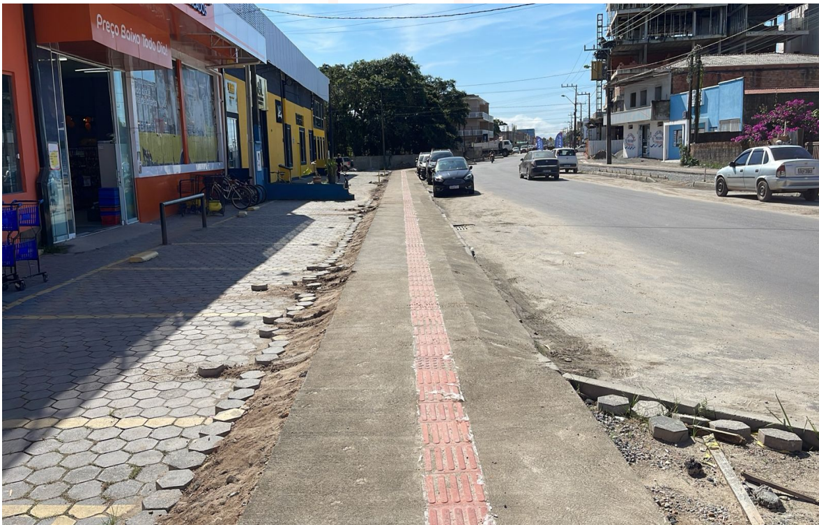
fig. 14 – Detalhe da rampa de acesso aos lotes.
