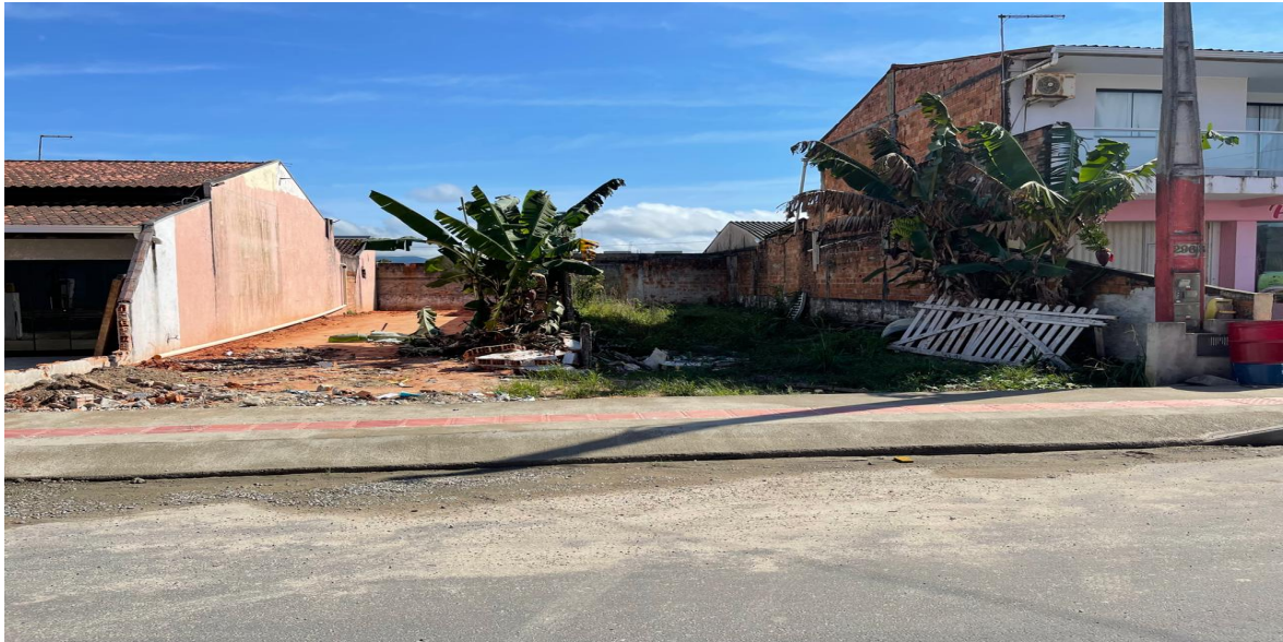
fig. 11. – Detalhe da rampa de acesso aos lotes.
