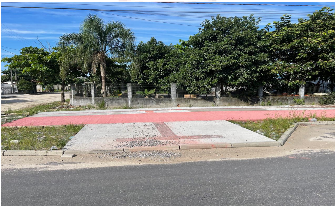
fig. 9 – acesso a travessia elevada, trecho da ciclovia.
