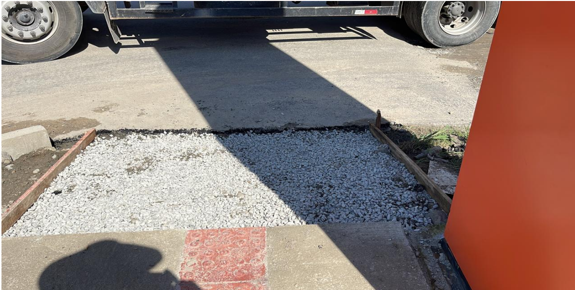
fig. 6 – detalhe dos ajustes nos meios fios, ciclovia.
