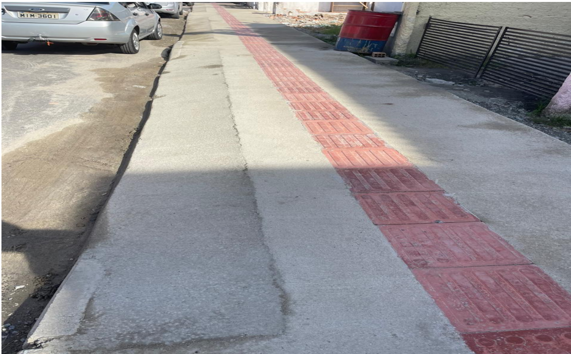
fig. 15 – Detalhe da rampa de acesso aos lotes
