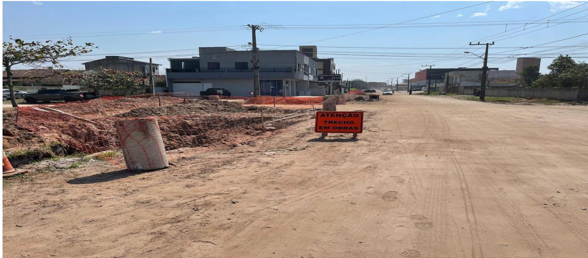
fig. 1 - Rede pluvial de 40 cm, deságue tubulação de 60 cm, Estaca 0+320.
