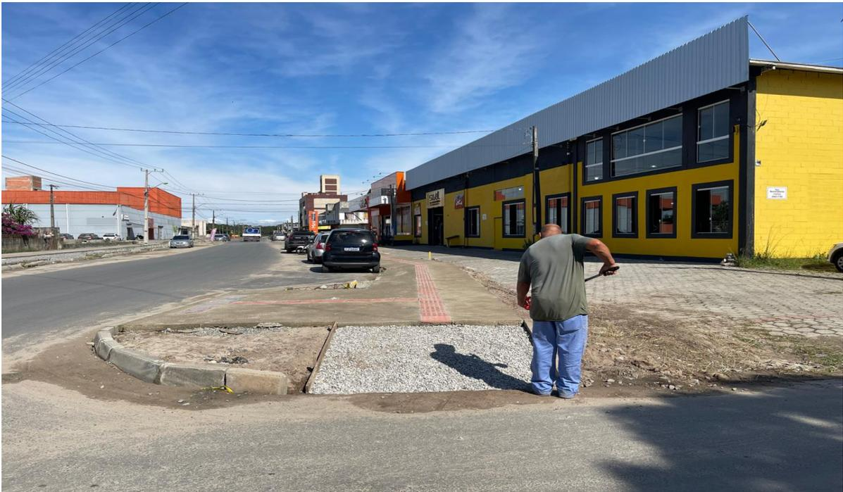
fig. 7 - detalhe dos ajustes nos meios fios, passeio.
