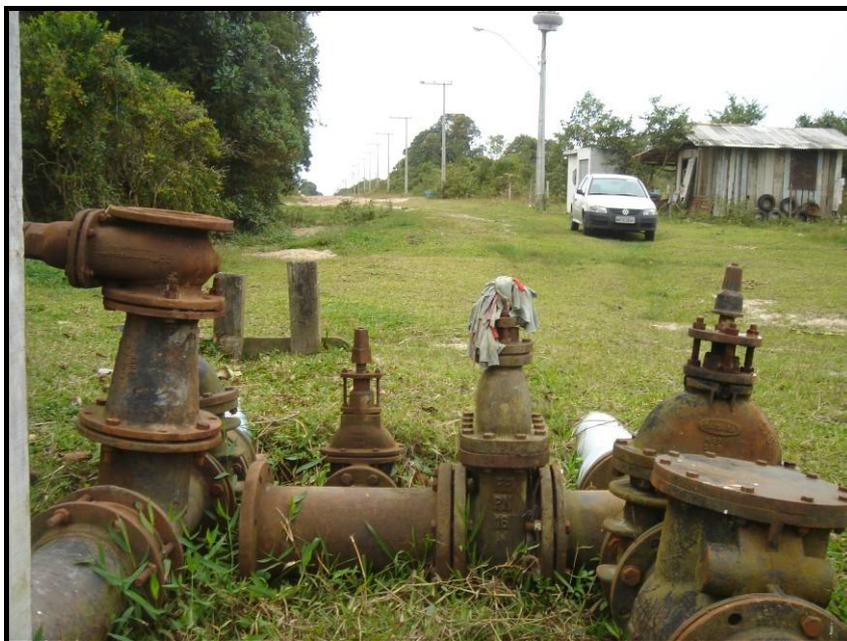
Figura 24 - Adutoras da ETA Principal – 2 de DN 200 em Ferro fundido
