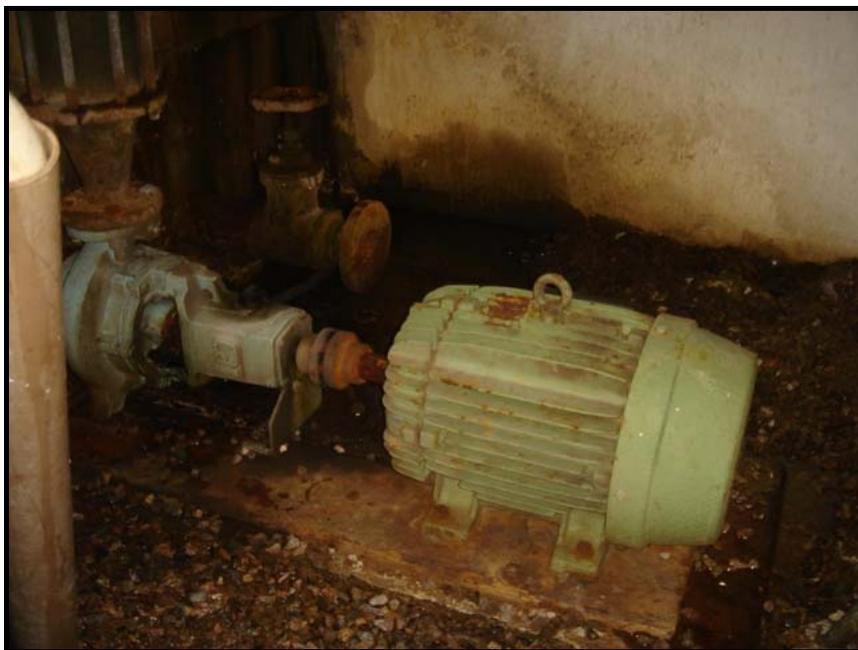
Figura 25 – Bomba de Recalque de Água Tratada
