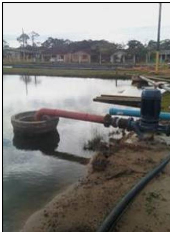
Figura 33 – Detalhe da Captação da Água Clarificada na Lagoa de Decantação 3
