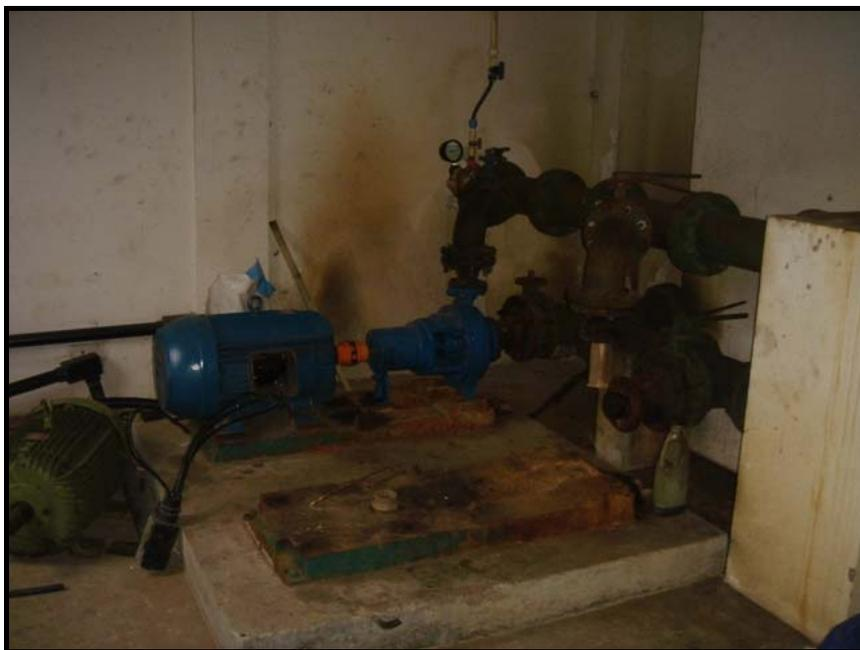
Figura 26 – Bomba de Recalque de Água Tratada
