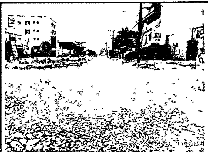
Sub-base irregular e contaminada e base irregular por conta da paralisação
