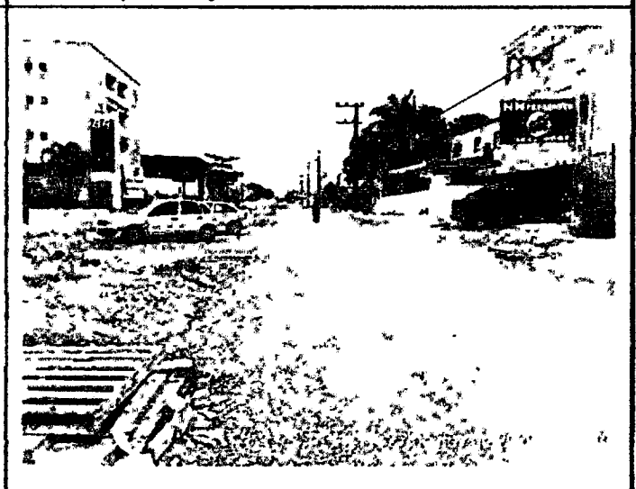
Base irregular por conta da paralisação
