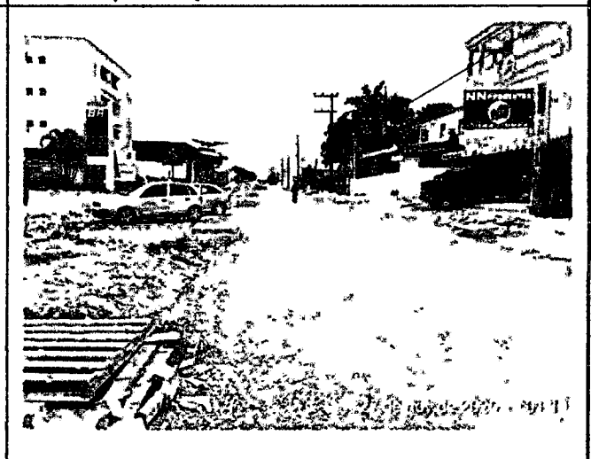
Base irregular por conta da paralisação
