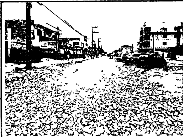
Sub-base irregular e contaminada, base não iniciada
