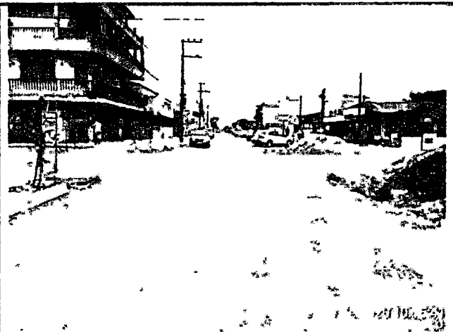
Base irregular por conta da paralisação
