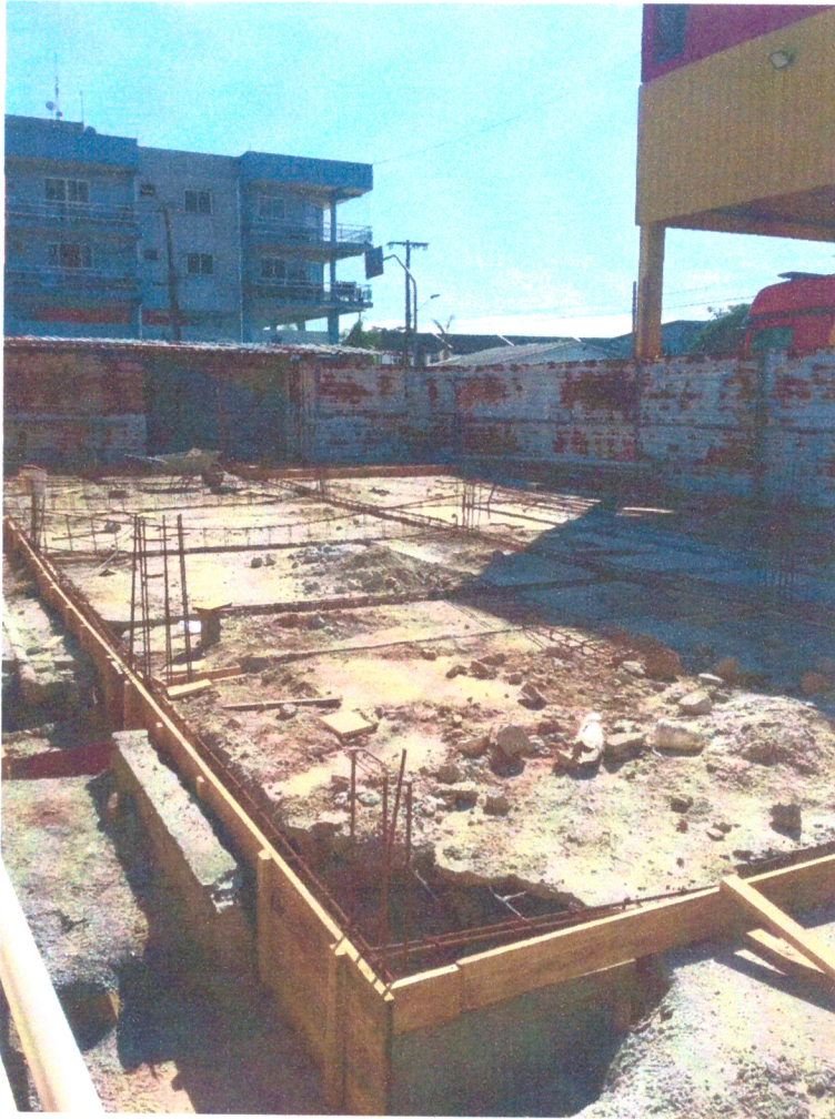
Figura 4 – Piso Concreto existente
