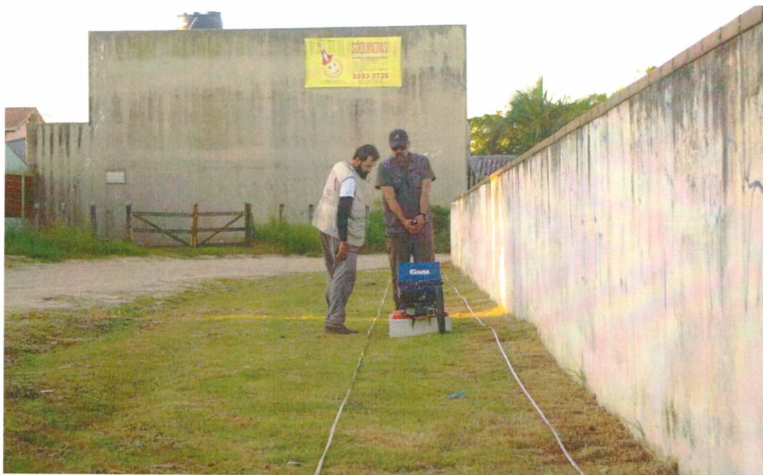
Figura 15: Utilização de equipamento de GPR para penetração de solo.
